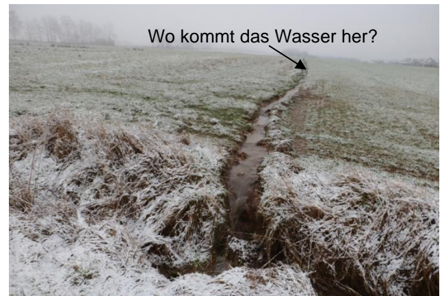
Abb. 1: Entwässerungsgräben quer über die Fläche. Eine sinnvolle Maßnahme?
